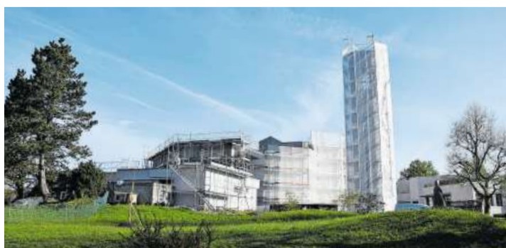
Sowohl Kirchengebäude als auch Turm sind in Rotmonten seit kurzem von einem Baugerüst umhüllt. Bild: zvg
