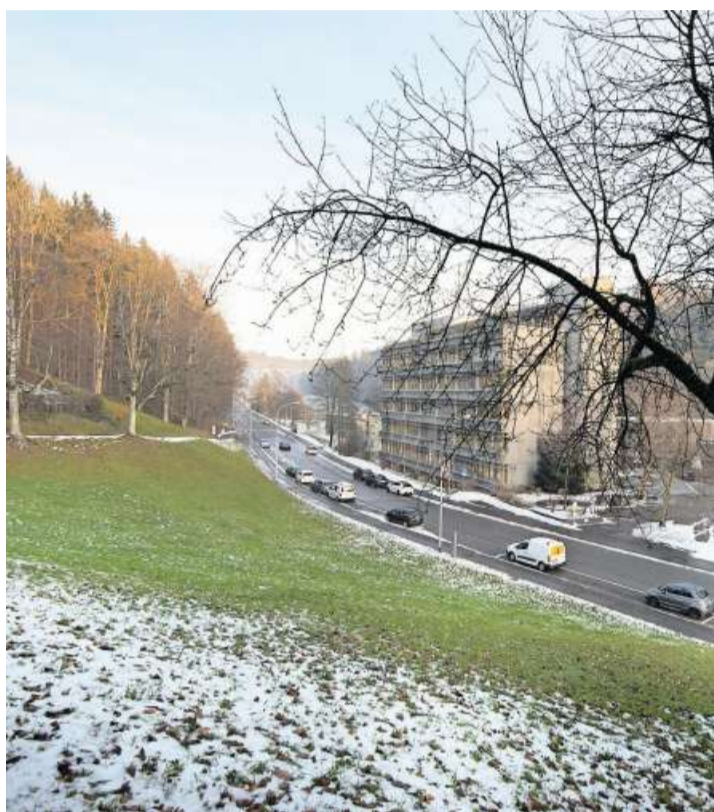
Bald fahren auf dieser Wiese Bagger auf: Nach jahrelangem Rechtsstreit starten Mitte Februar die Bauarbeiten für die Alterswohnungen im Riethüsli. Bild: Ralph Ribi
