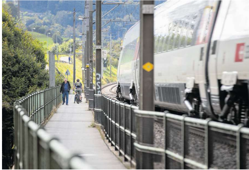
Der Fuss- und Veloweg wird abgebrochen und ein neuer, vier Meter breiter Steg verankert.
