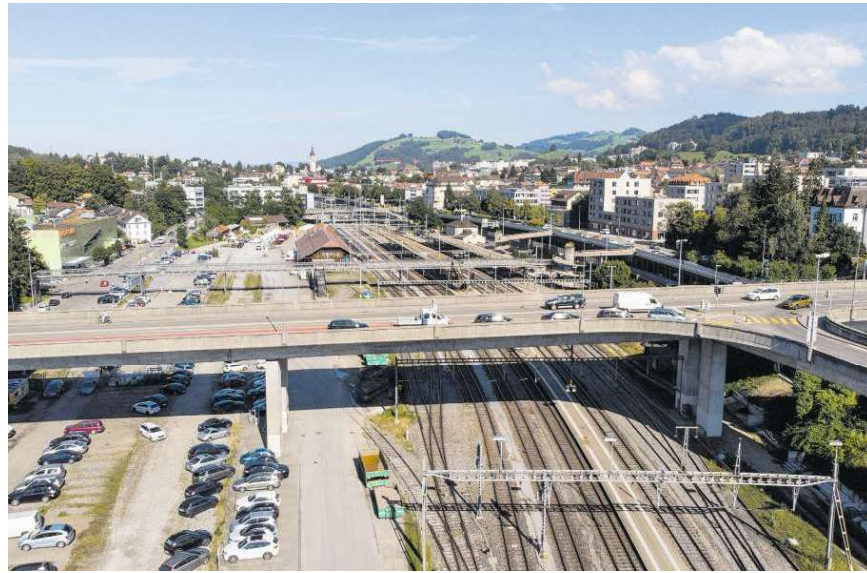
Die Gesamtüberdeckung in St. Fiden hat im Parlament eine wichtige Hürde genommen.
